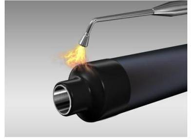
2.9. Правильно установленная заглушка не должна иметь прожогов, разрывов и других дефектов; плотно облегать изолируемые участки, повторяя рельеф поверхности.
